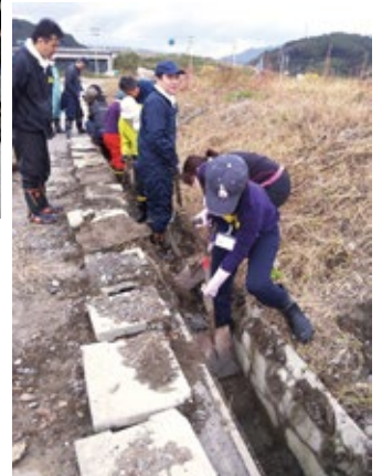
側溝泥出し作業
