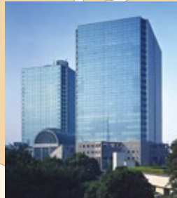
1991年 東京本社移転 (東京都港区 シーバンスN館)
