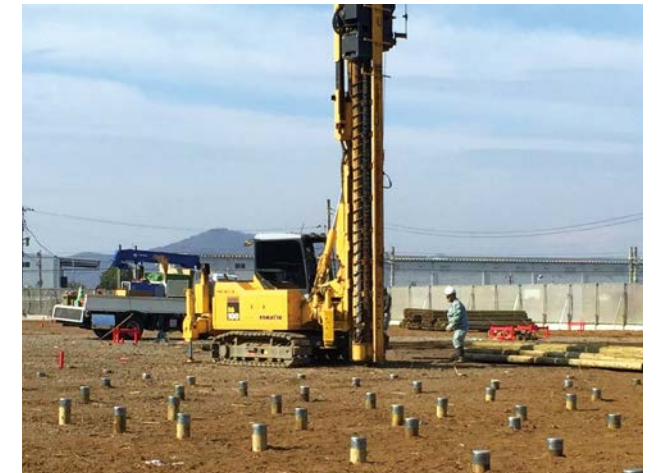
保存処理木材を使用した地盤補強の様子
