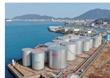
兼松油槽 / 小倉油槽所の陸上タンク
